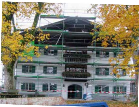
**Dezember 2015** Der Altbau versteckt sich hinter dem Gerüst – hinter den Wänden und Decken im Dach verstecken sich Holzwurm und Pilz – wir müssen den Dachstuhl erneuern. Wieder eine Verzögerung, wieder erhöhte Kosten
